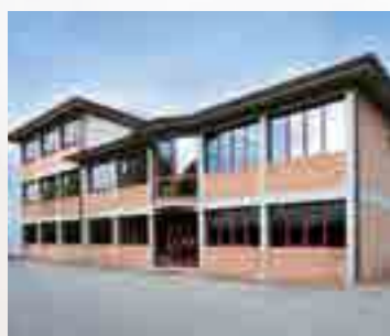
Siège de Tecno-Gaz Sede de Tecno-Gaz
