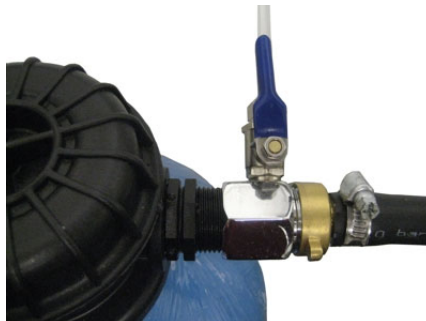
Fig. 12: Robinet de décharge ouvert (pour échanger la cartouche)
