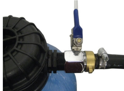
Abbildung 12: Ablasshahn offen (zum Wechsel der Kartusche)
